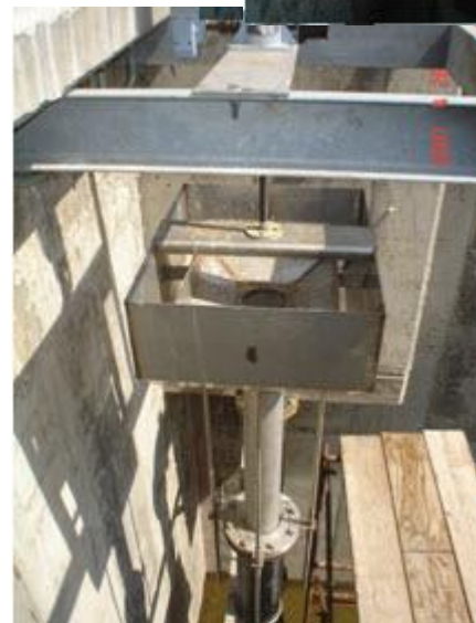
AIRE-02® ร่วมกับ Wagner Fluid Systems® พัฒนาอุปกรณ์ถ่ายน้ำสี่ชนิดไหลลง 4 ทิศทาง (Four-Sided Controlled Decanter) ปรับขึ้นลงด้วยชุดขับเคลื่อนเกียร์มอเตอร์เพื่อประสิทธิภาพสูงสุดของการระบายถ่ายน้ำใสออก
