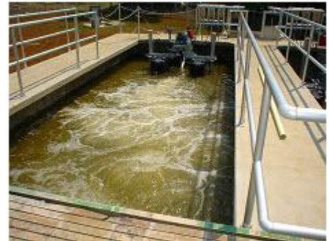
เครื่องเติมอากาศ/กวนผสม Triton ทำการเติมอากาศและกวนผสมไปพร้อมกัน
