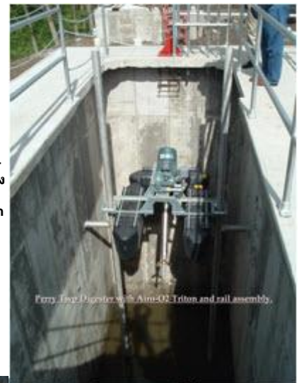
เครื่องเติมอากาศ/กวนผสม Triton® Aerator / Mixer เคลื่อนตัวขึ้นลงตามโครงสร้างไปตามระดับน้ำ
